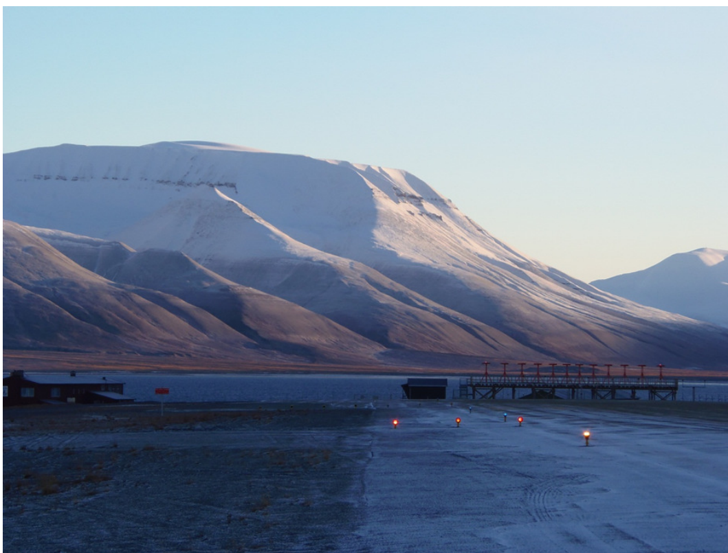
Figur 4.4.1.A. Svalbard lufthavn har høyt terreng (Operafjellet) øst for plassen. Dette medfører at innflygingen til bane 28 er off-set med 16°. Ved utflyging østover med større mellomstore jettfly må det gjennomføres venstresving umiddelbart etter avgang.
