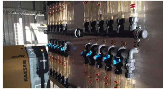
Luft pumpes ned i jord og grunnvann for å øke nedbrytning
